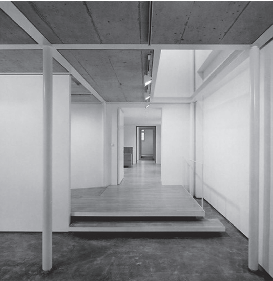
Die Ausstellungshalle im Eingangsbereich. Die Ausstellungsebenen wurden als Stahlbetonkonstruktion in den grossen Ökonomieraum des Tenns eingebaut.
