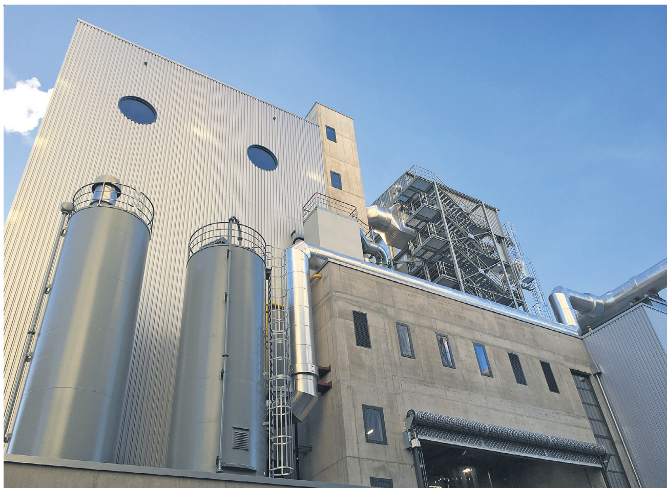
Das Holzkraftwerk Basel II produziert ab 2019 CO 2 -neutrale Fernwärme.
