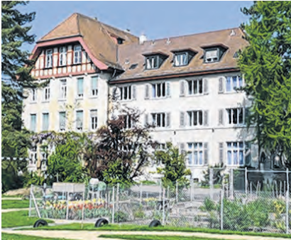
Das Haupthaus der Guten Herberge wird zurzeit saniert.
