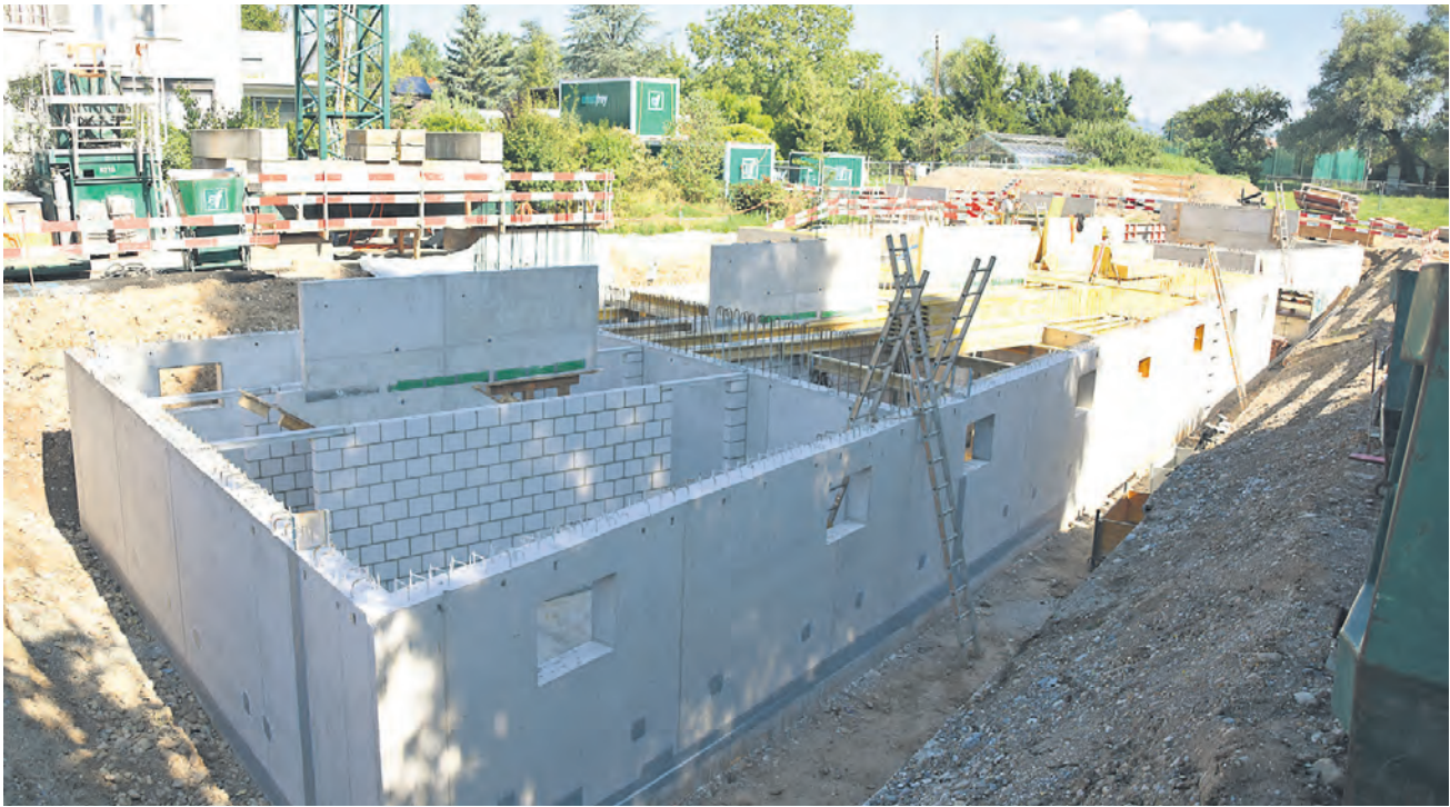
Beispiel Wohnungsbau – Baustelle der Bau- und Wohngenossenschaft Höflirain, die als Baurechtsnehmerin der Gemeinde an der Grendelgasse Reiheneinfamilienhäuser errichtet.
