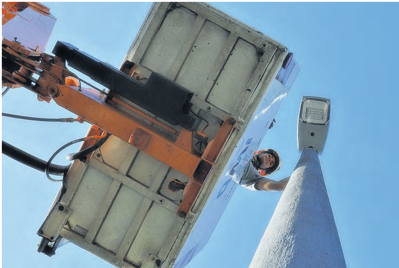
Die neuen LED-Leuchten mit Bewegungssensoren wurden an den alten Standorten installiert.
