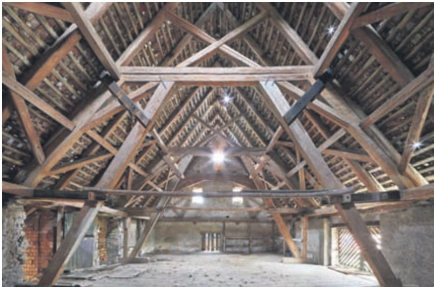
Aufgenommen vor der Sanierung, die Dachkonstruktion von innen, die eine Hauptattraktion des neuen Innenraums bildet.
