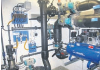
Herzstücke der Technik: der neue Schaltschrank und die Pumpen.
