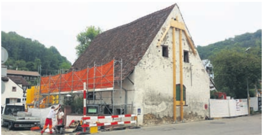
Das Foto in der Anfangsphase der Arbeiten zeigt das ursprüngliche Erscheinungsbild der Baslerhofscheune von der Hauptstrasse her.
