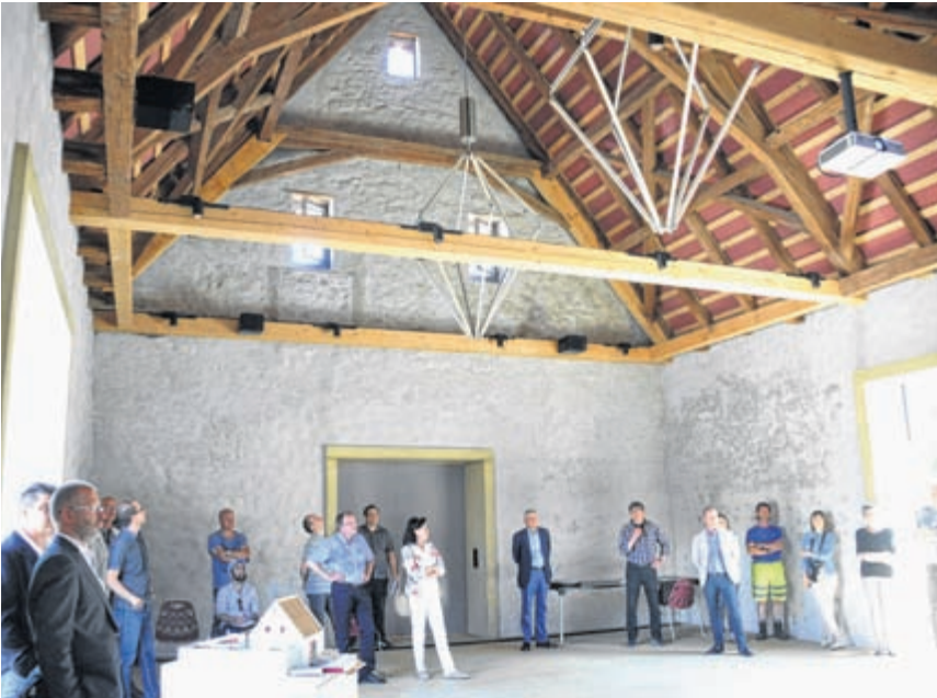
Der Innenraum der ehemaligen Feldscheune, die wieder zum eingeschossigen Gebäude mit offen sichtbarer Dachkonstruktion zurückgebaut worden ist.
