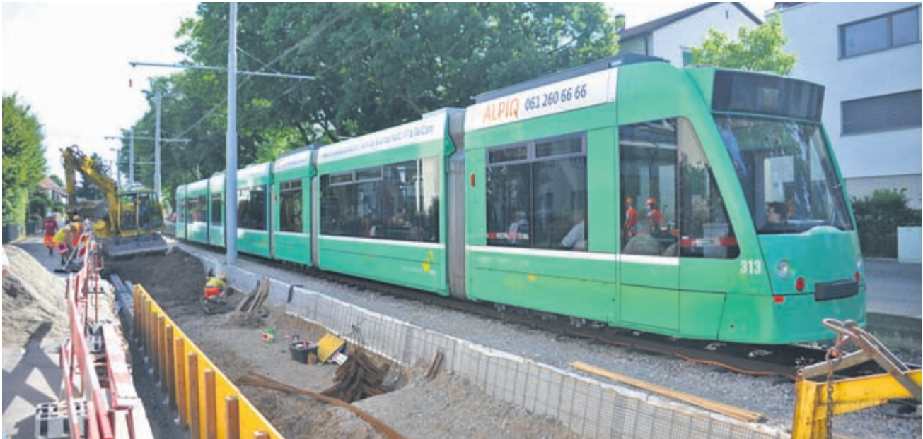
Bauen unter Betrieb – Baustelle und BVB-Tram auf dem Abschnitt zwischen Bäumlhofstrasse und Niederholzboden.
