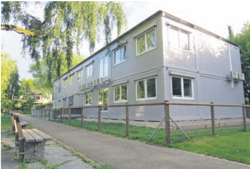
Das zweigeschossige Kindergartenprovisorium in der Essiganlage wird ab Montag zum Leben erwachen.
