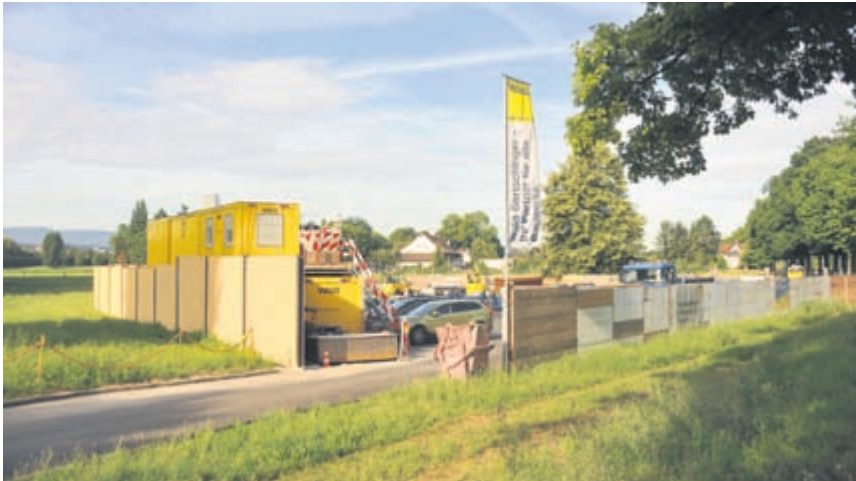
Einfahrt zum Baustellen-Installationsplatz an der Riehenstrasse bei den Habermatten von Riehen her gesehen.
