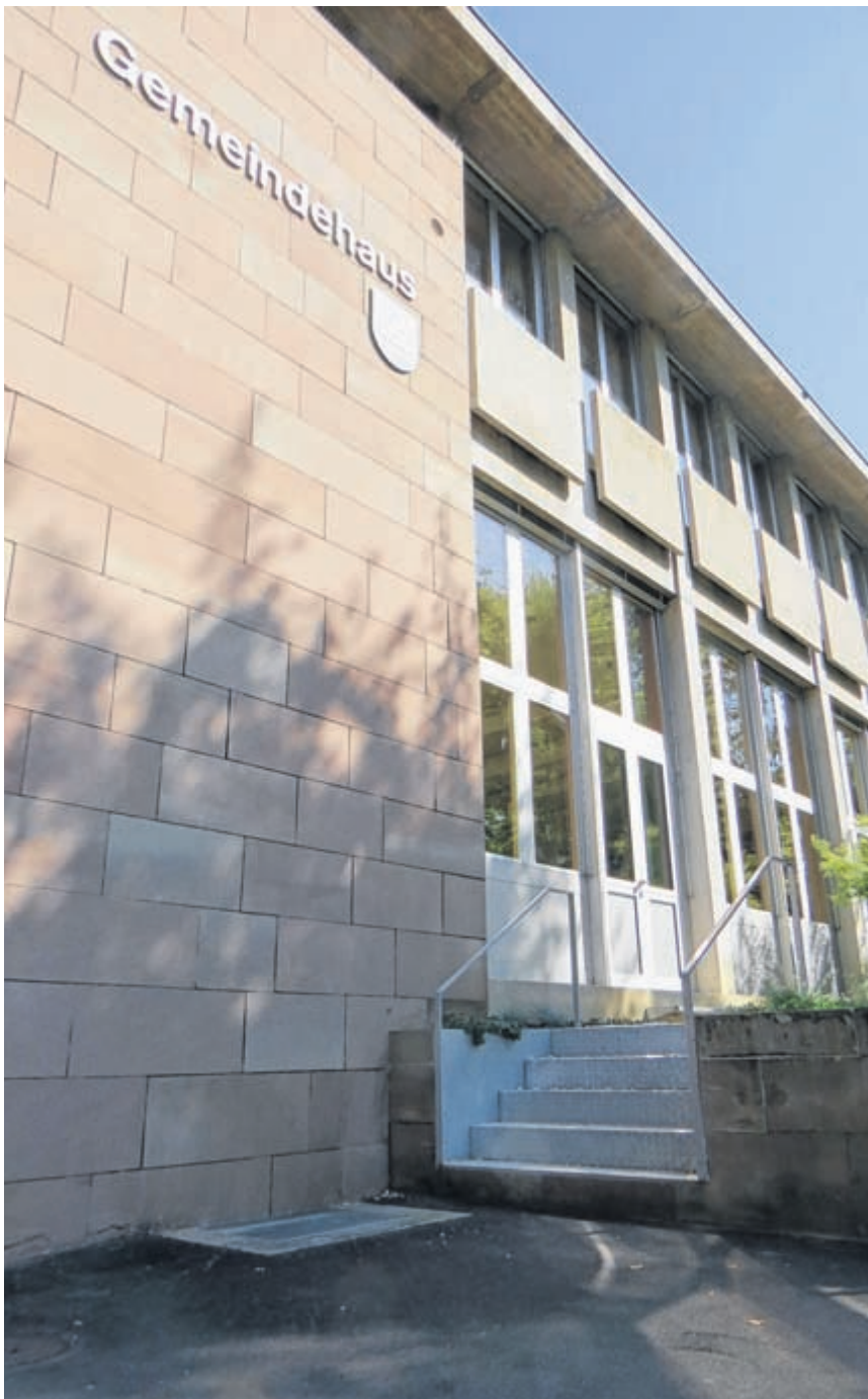
Flucht auf den Parkplatz: Der zusätzliche Notausgang des Bürgersaals führt direkt ins Freie.
