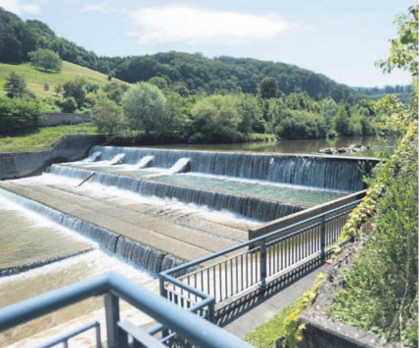
Das Kleinwasserkraftwerk Neuwelt der IWB in Münchenstein wird demnächst nach den neuesten Standards des Gewässerschutzes saniert.
