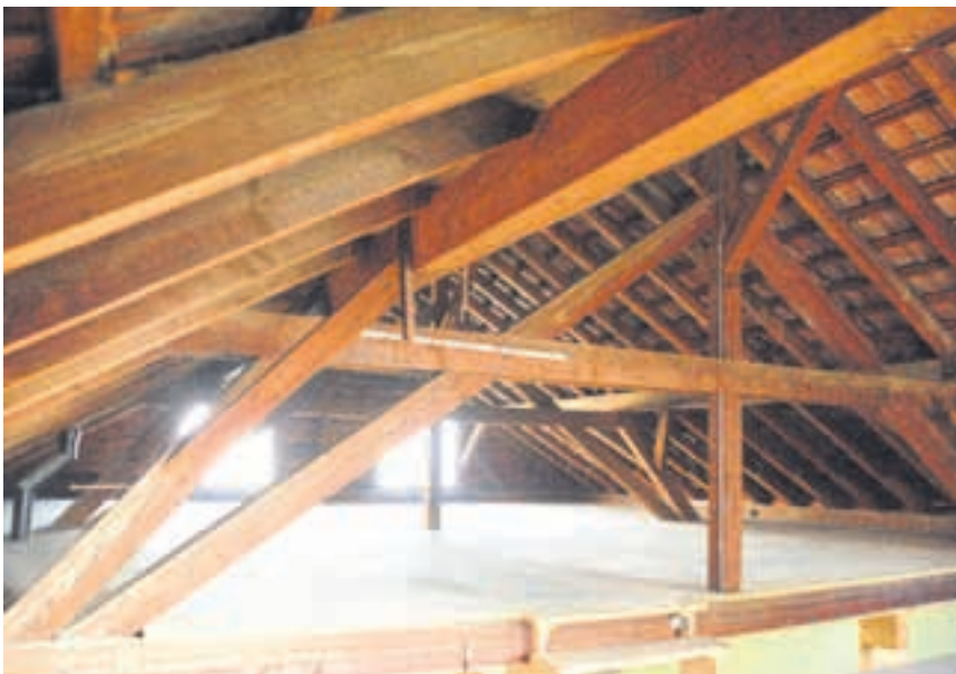
Der inzwischen ausgeräumte Estrich mit seiner offenen Dachkonstruktion soll zur Spiellandschaft für jüngere Kinder werden.
